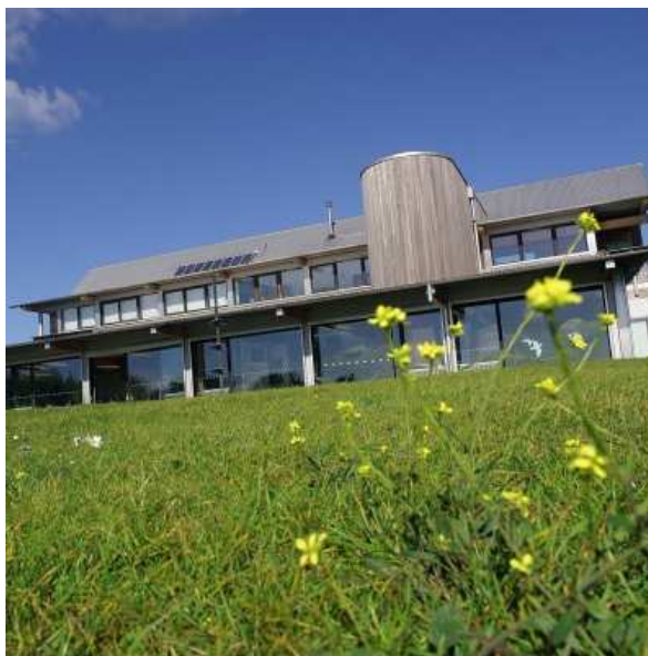
Instalações no Millennium Eastbrookend Country Park
